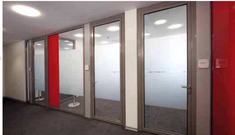
▲ Raumhohe, transluzent, gestaltete Glastrennwände mit rot lackierten Farbtupfern sorgen in der Kundenberatung für höchste akustische Ansprüche
