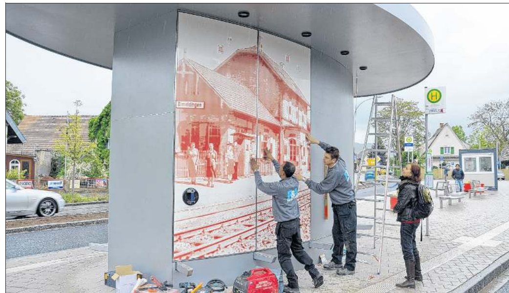
Zwei Tage lang arbeiteten Fachleute der belgischen Firma, um das Kunstwerk der Eimeldinger Künstlerin Tanja Bürgelin-Arslan am Eimeldinger Busbahnhof zu installieren. Foto: Marco Schopferer
